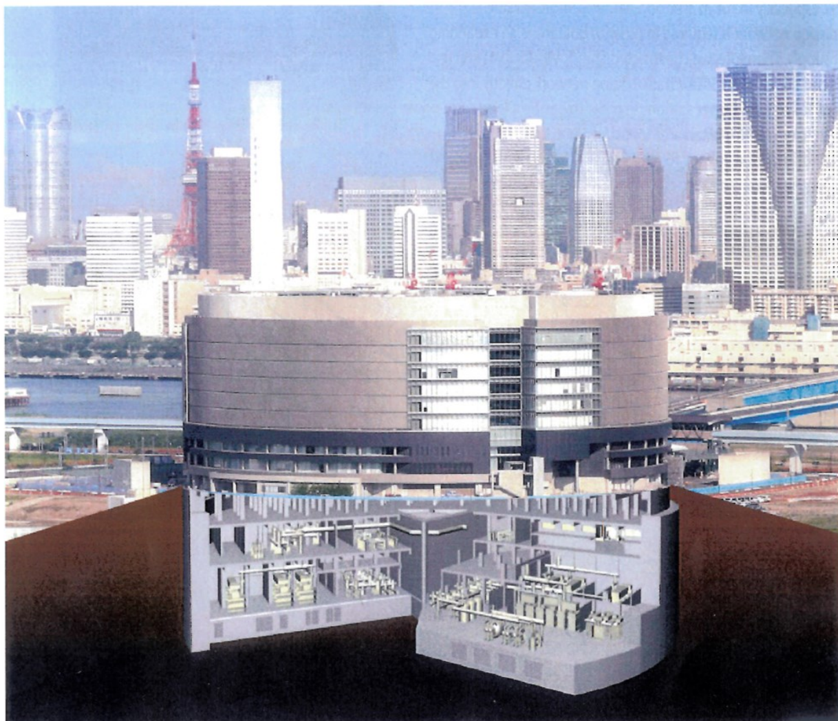
Рис.5 GIS ПС 500 кВ г.Токио (Япония)
