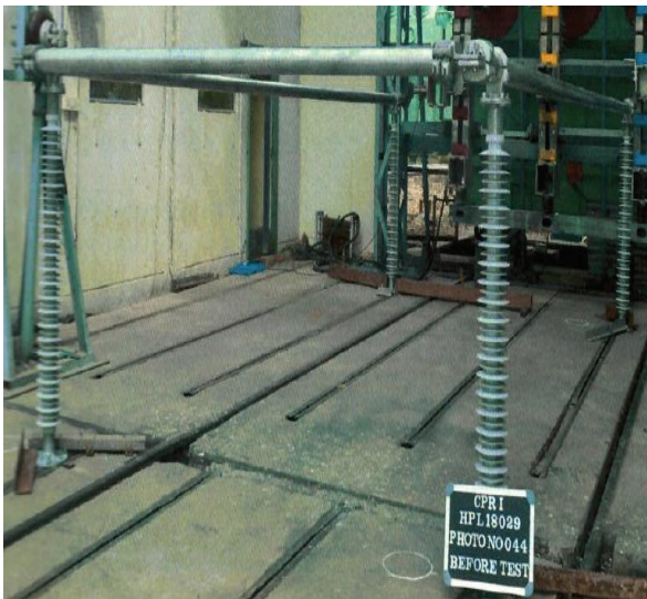
Рис.9 Испытательное устройство 132 кВ перед испытанием на короткое замыкание
