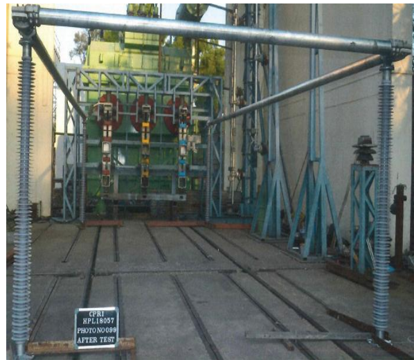
рис.12 После испытаний на к.з. 220 кВ
