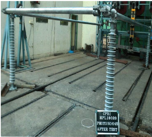
Рис 11 После испытаний на к.з. 132 кВ
