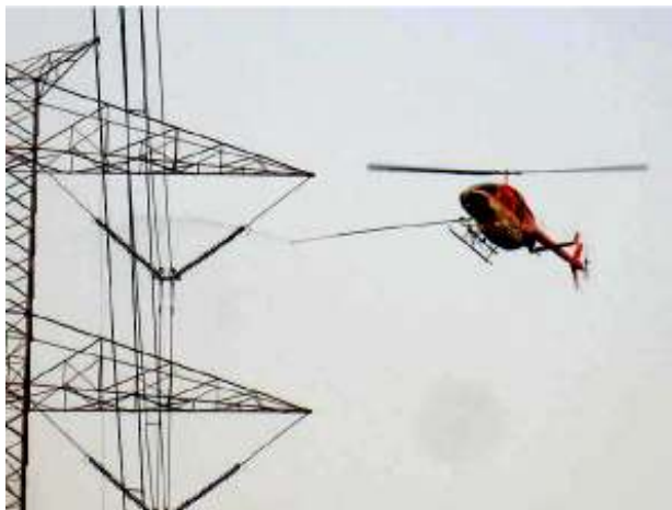
Рис.16. Очистка изоляторов от загрязнений с применением вертолѐта
