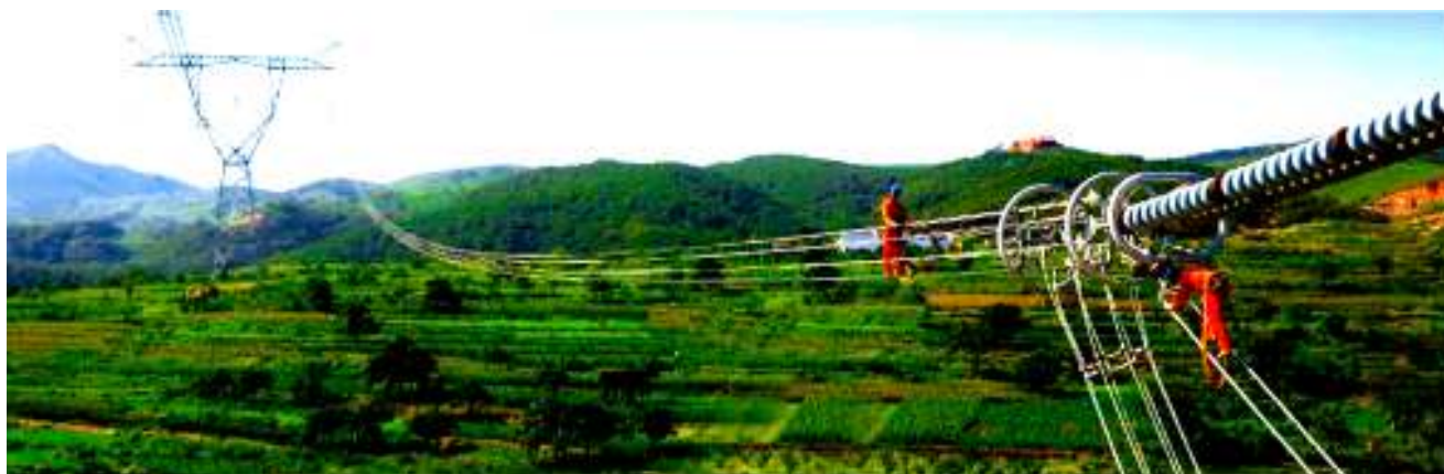
Рис. 1. Монтаж проводов на ВЛ УВН в Китае
