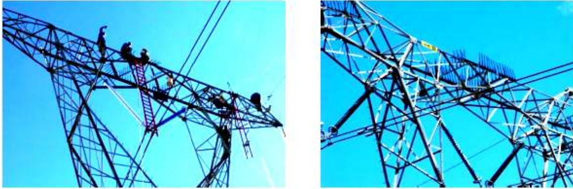
Рис.14. Замена стеклянных изоляторов композитными на ВЛ 400 кВ
