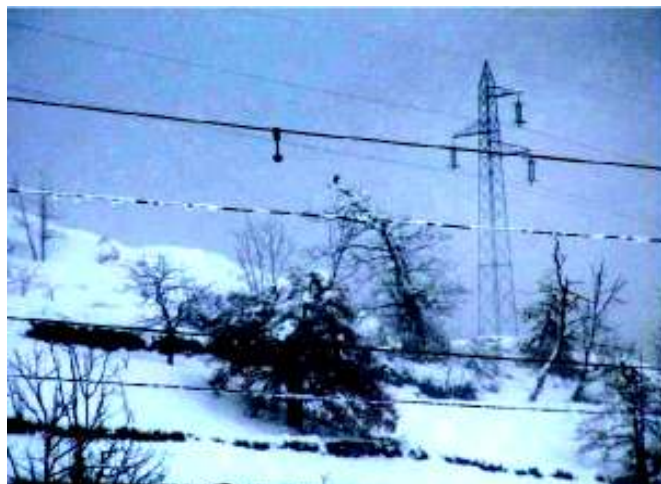
Рис.7. Налипание мокрого снега на провод с противовесом и без него.
