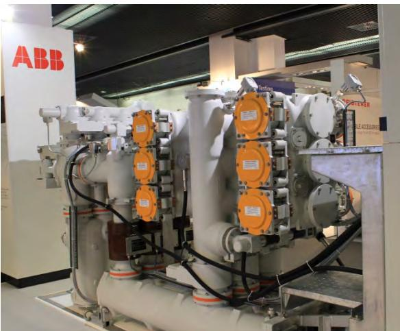
Рисунок 7 – Элегазовый выключатель компании ABB
